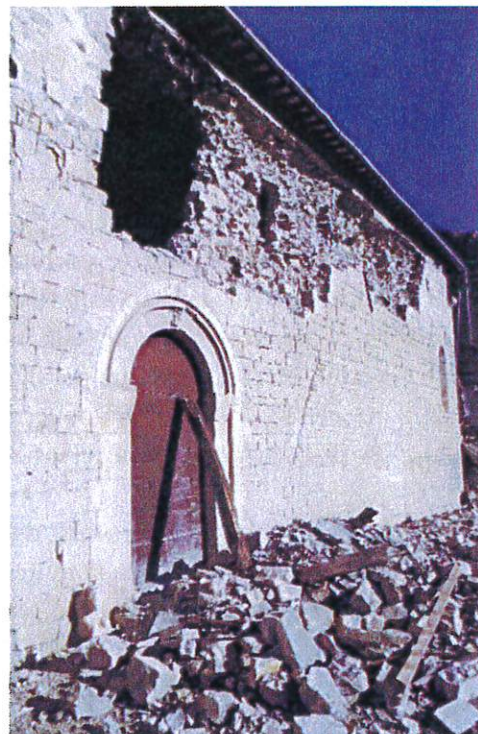
Figure 10-11 A sinistra, crollo parziale della muratura al di sotto di cordolo in calcestruzzo, con ancoraggi in verticale rimasti liberi. Visso (MC). A destra, Chiesa di S. Stefano a Castelsantangelo sul Nera (MC), caduta del paramento esterno nella zona sottostante il cordolo.
