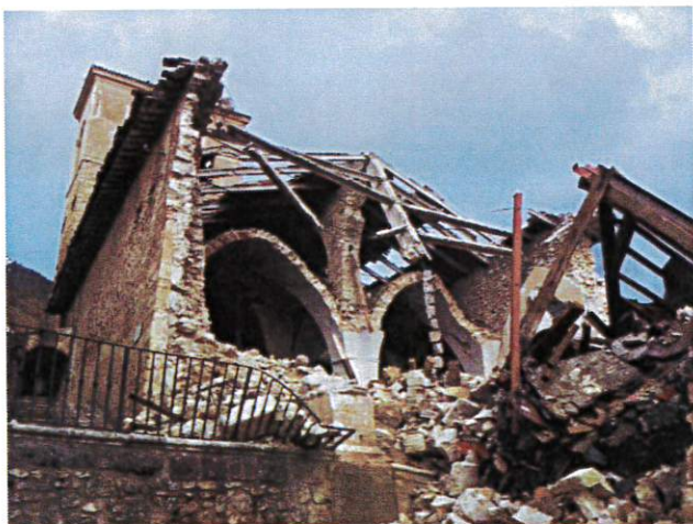
Figura 23 Chiesa di S. Andrea a Campi di Norcia, con copertura a travi Varese e tavellonato, poggiati su trave di colmo in calcestruzzo e cordolo cementizio perimetrale
