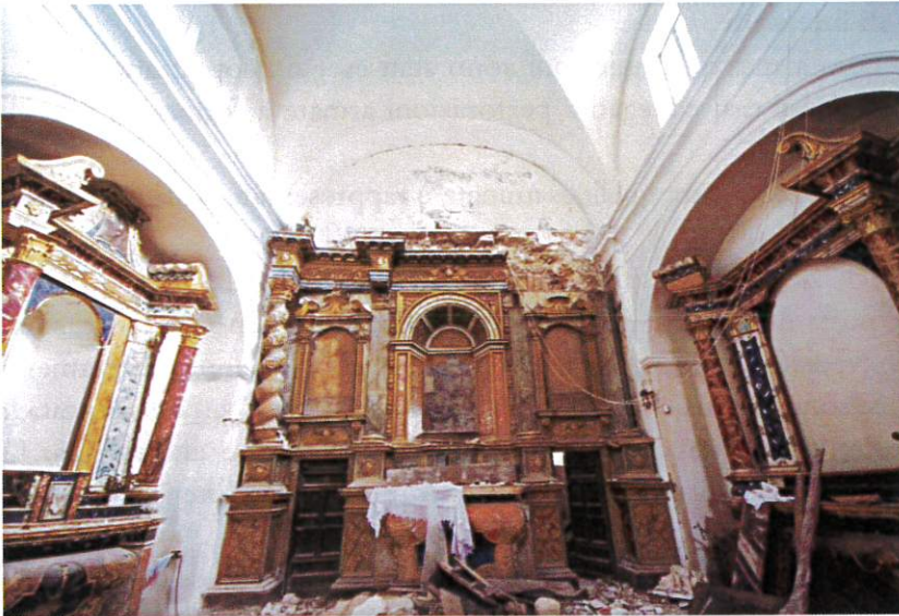
Figure 5 Interno della chiesa di S. Procolo ad Avendita di Cascia (PG)
